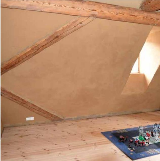
Abbildung 18: Lehmputzplatten verfügen über ein großes Feuchtespeichervermögen, Bildquelle: Lehmix, Hart-Keramik.
