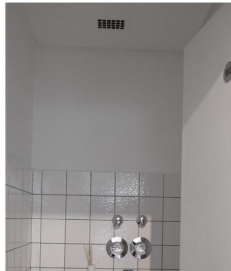
Abbildung 66: Abluftdurchlässe eines Schachtlüftungssystems
