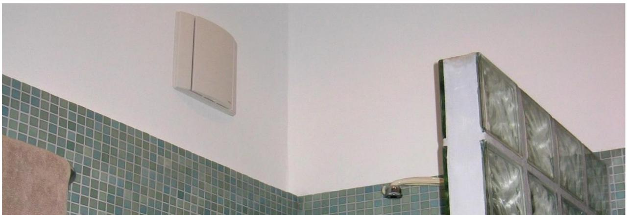
Abbildung 65: Abluftventilator eines Entlüftungssystems nach DIN 18017-3
