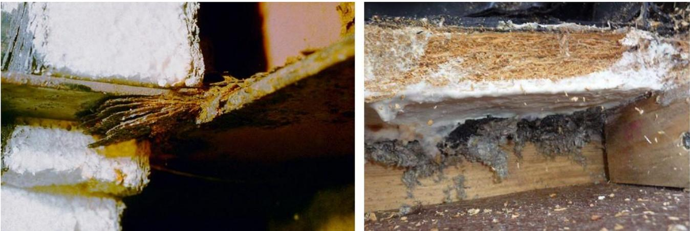
Abbildung 33: fatale Feuchteschäden in Außenbauteilen hervorgerufen durch Konvektionsströmungen: linkes Foto massive Korrosionserscheinungen und rechtes Foto Fäulnis und Schimmelpilzbildung in Bauteilschichten
