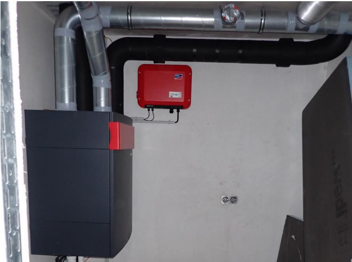
Abbildung 25: Wohnungszentrales Zu- / Abluftsystem mit Wärmerückgewinnung
