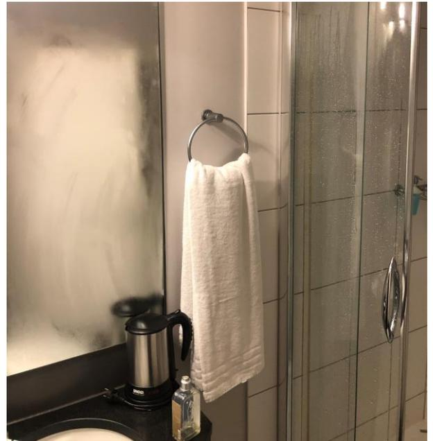
Abbildung 19: Auffeuchtung nach dem Duschen ohne Feuchtespeicherung. Tauwasserbildung auf Spiegel und Fliesen.
