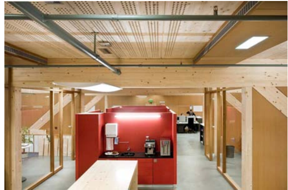
Links: LIGNATUR-Flächenelemente werden montiert. Rechts: LIGNATUR nutzt auch für das eigene Bürogebäude seine Decken- bzw. Dachelemente, hier mit Akustiklochung. (Bildquelle: Lignatur AG)
