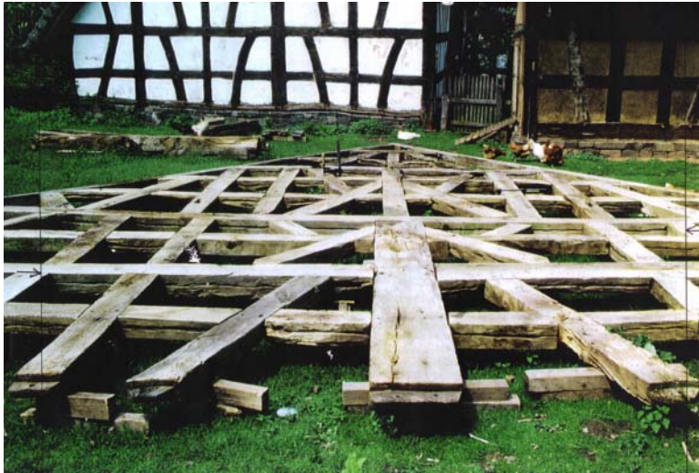
Links: Liegendes Fachwerk ohne Ausfachungen Rechts: Viergeschossiges altes Fachwerkgebäude
