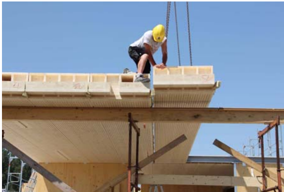
Links: LIGNATUR-Flächenelemente werden montiert. Rechts: LIGNATUR nutzt auch für das eigene Bürogebäude seine Decken- bzw. Dachelemente, hier mit Akustiklochung. (Bildquelle: Lignatur AG)
