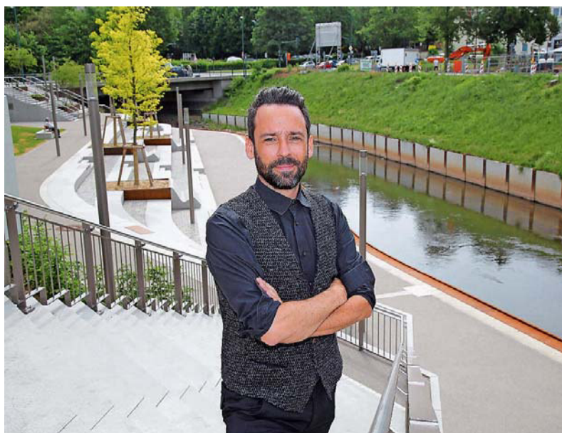
Landschaftsarchitekt und Stadtplaner Luca Kist auf den Bliesterrassen mit dem fertigen Nordufer (links) und dem „unsexy“ Südufer.
