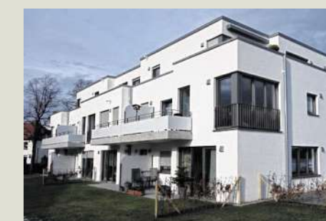
Errichtung von seniorengerechten Wohnungen am Senioren- und Pflegezentrum St. Josefhaus mit 18 Wohneinheiten 52477 Alsdorf, Alte Aachener Straße/ Dr.-Helmut-Eckert-Straße 2 Architekt: Michael Heins Besichtigung: Sa. 24.6., 14-16 Uhr Foto: Michael Heins
