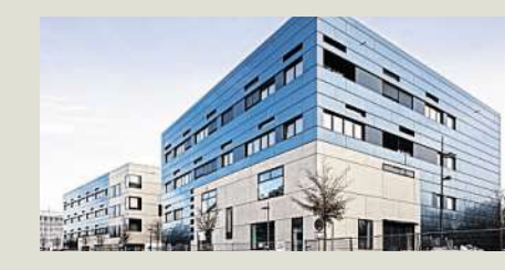
NGP 2 Aachen, Forschungsgebäude „Center for Next Generation Processes and Products“ 52074 Aachen, Forckenbeckstraße 60 Architekt: Professor Johannes Kister Besichtigung: Sa. 24.6., 13-17 Uhr, Führungen zur vollen Stunde Foto: Jörg Hempel
