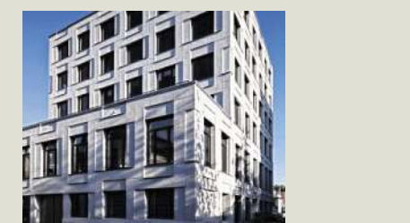
Neubau Amtsgericht Erkelenz 41812 Erkelenz, Konrad-Adenauer-Platz 3 Architekten: Michael Großmann, Gesine Weinmiller Besichtigung: Sa. 24.6., 10-14 Uhr Foto: Michael Großmann
