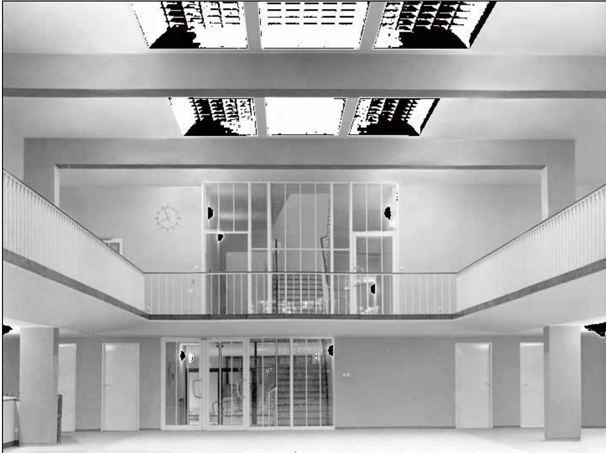
Abb. 6: Henry-Ford-Bau, SW- (Südwest-) Flügel, nach Neuordnung der Rettungswege (Foto: Freie Universität, Alexander Matt)
